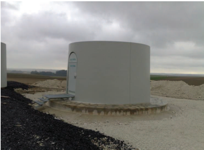
Photographie 1. Fixation de la base du mât
