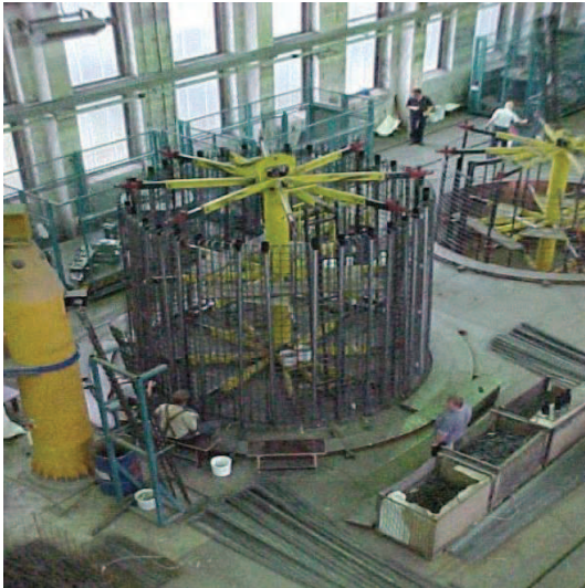
Armature métallique des segments en béton
