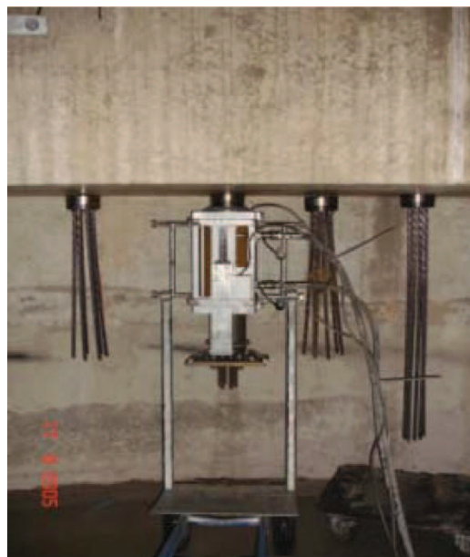
Figure 12 : Fixation des torons de tension à la base du mât (source : Enercon)
