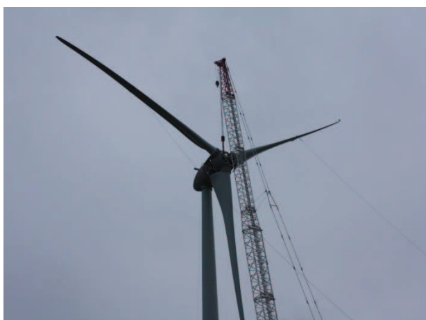
Photographie 5. Fixation du rotor à la nacelle
