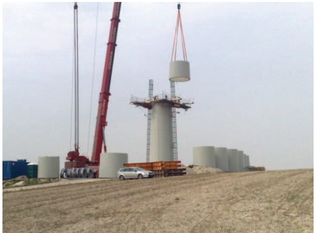
Photographie 2. Assemblage du mât en béton
