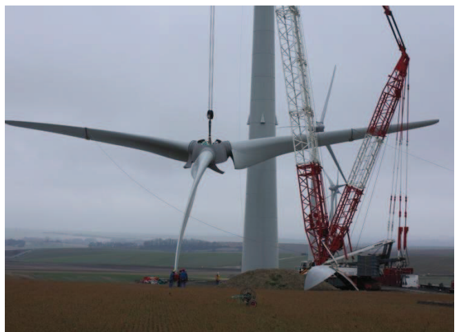
Photographie 4. Assemblage et levage du rotor
