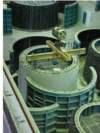
Décoffrage d'un segment en béton
