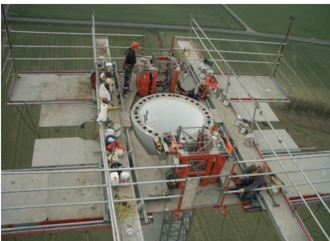
Photographie 3. Plateforme mobile d'assemblage du mât
